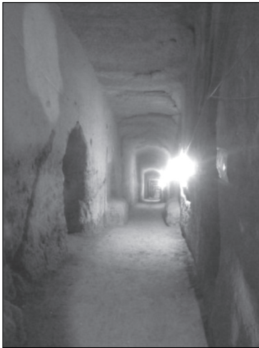
تصویر ۱۷- راهرو دراز آسیاب دوسنگی به طول ۱۶۰ متر با شیبی ملایم. (مأخذ: نگارنده)
